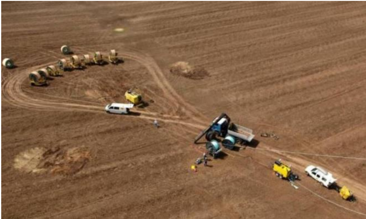
Abbildung 2-8: Trommel- und Windenplatz für Seilzug (Quelle: 50Hertz Transmission GmbH)
